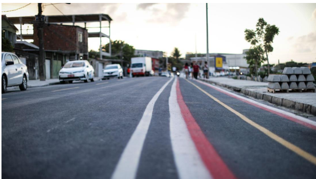
Obras de nova avenida nas margens do rio Beberibe - Foto Rodolfo Loepert/PCR
