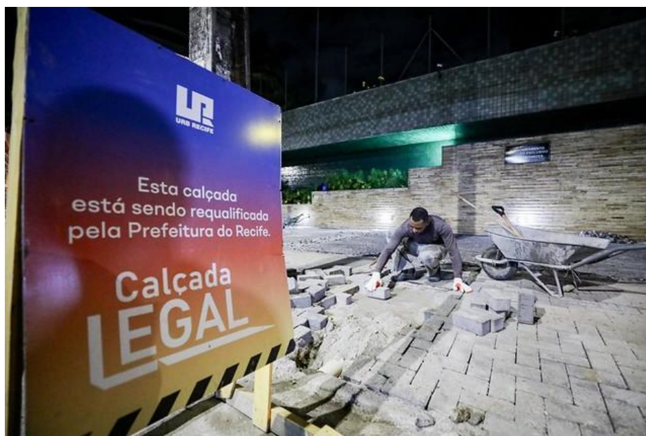
Programa Calçada Legal - obras de requalificação na Avenida Dezanete de Agosto, em Casa Forte. Foto: Edson Holanda/ PCR
