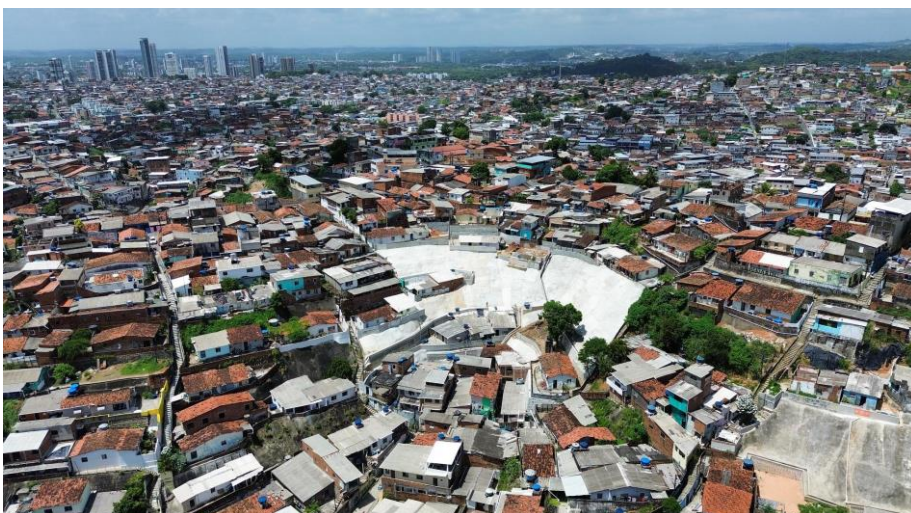
Obras de contenção de encostas no Alto do José Bonifácio. Foto: Diego Nigro e Rodolfo Loeper/ PCR
