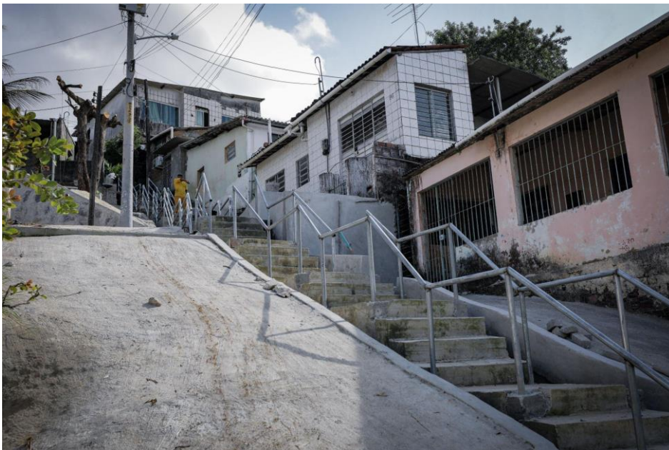
Programa Rua Tinindo no Jordão - Obras de requalificação na Rua 22 de Agosto e Praça Criançada de Rua Foto: Edson Holanda/ PCR
