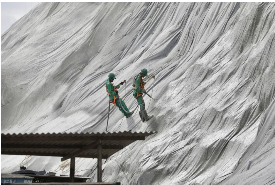
Colocação de Geomanta na Varzea. Foto: Hélia Scheppa/ PCR
