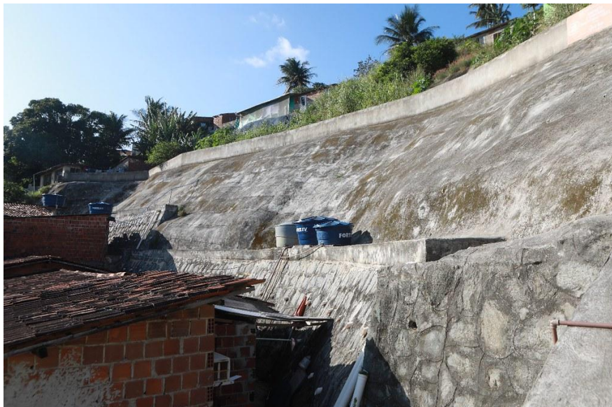
Obras de contenção definitiva de encostas no Córrego do Jenipapo. Foto: Wagner Ramos/PCR
