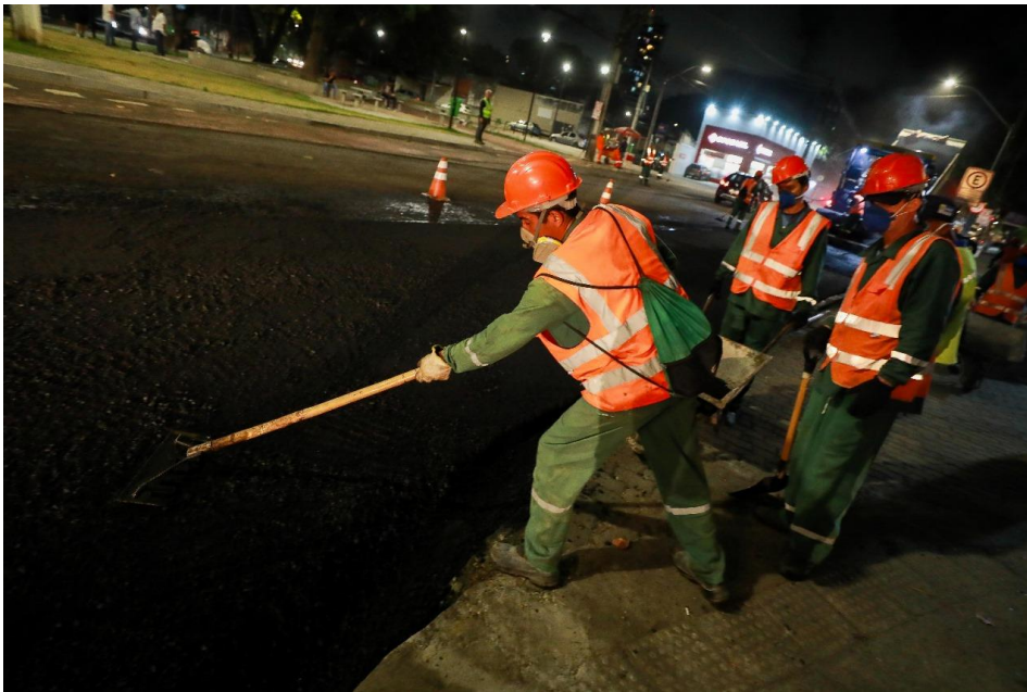
Programa Novo Asfalto - obra de recapeamento na Rua dos Palmares, em Santo Amaro Foto: Divulgação/ PCR
